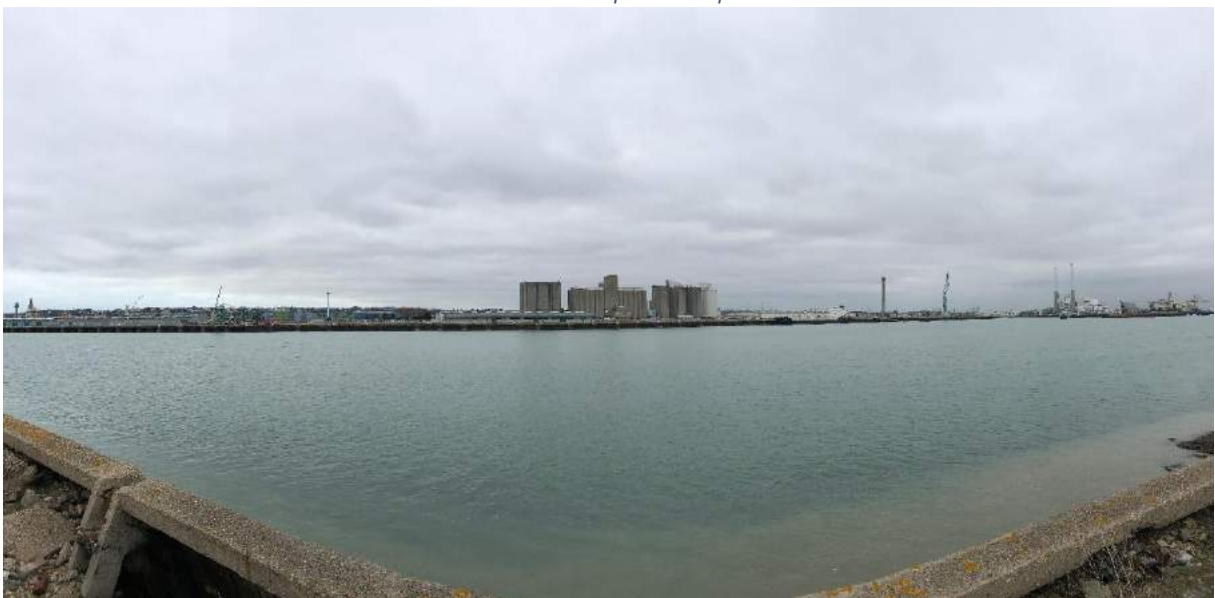
Photo 4. Vue Sud depuis le bassin pétrolier n°2
