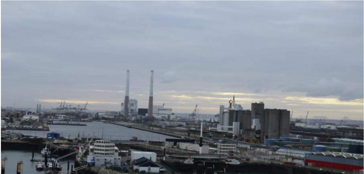
Photo 2. Vue Nord-Ouest du quai HDP depuis le quai Southampton
